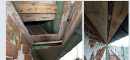
Die Traufbekleidung wurde erneuert. Links: Der Zustand vor der Instandsetzung mit 3-facher Traufverbreiterung, Rechts: nach der Instandsetzung.
