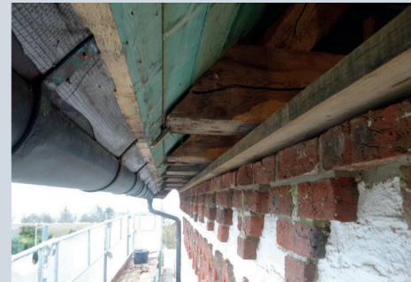
Neue Mauerschwelle Nordseite
