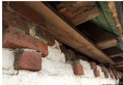
Geöffnete Verschalung im Traufkantenbereich
