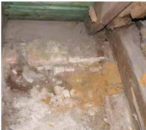
Beschädigter Sparrenfußpunkt, der Rest der Mauerschwelle ist stark zerstört
