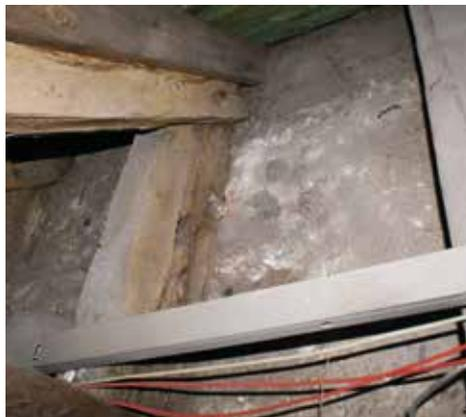
Stark geschädigter Deckenbalken, die Mauerschwelle ist nicht mehr vorhanden
