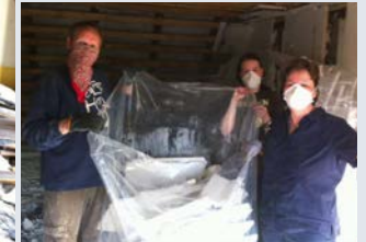
Entsorgung der Rigipsplatten.
