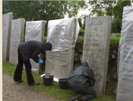
Wetterfest verpackt: Grabplatten während der Restaurierung
